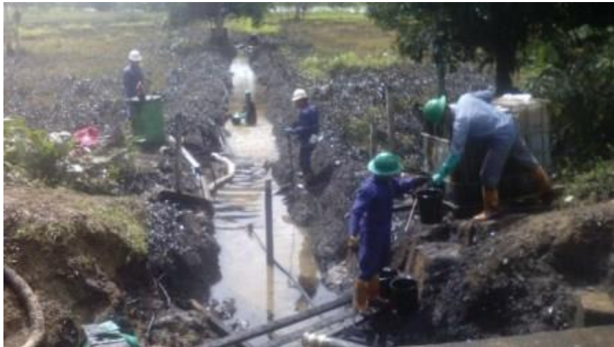
Limpeza de material vegetal
